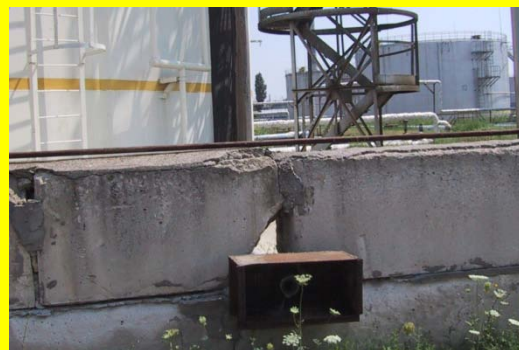
Juni – ett håll i en invallningsvägg
