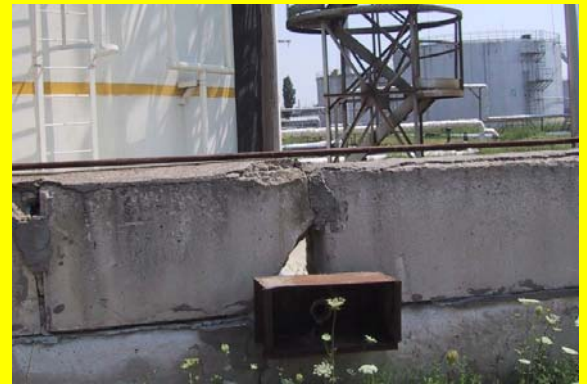
Maj – Beskadiget brandbeskyttelse på en rørbros støttebjælke
