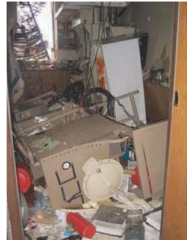
實驗室受損的情況
